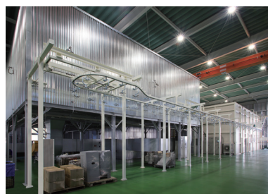
粉体塗装設備
